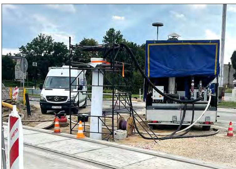
Ryc. 2. Typowa realizacja bezwykopowej renowacji kanalizacji – wprowadzanie „rękawa”
