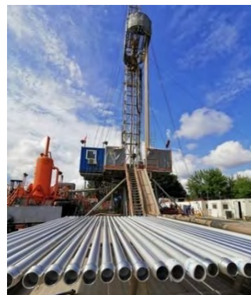
Ryc. 2. Kolumna filtrowa przygotowana do zapuszczenia do otworu
