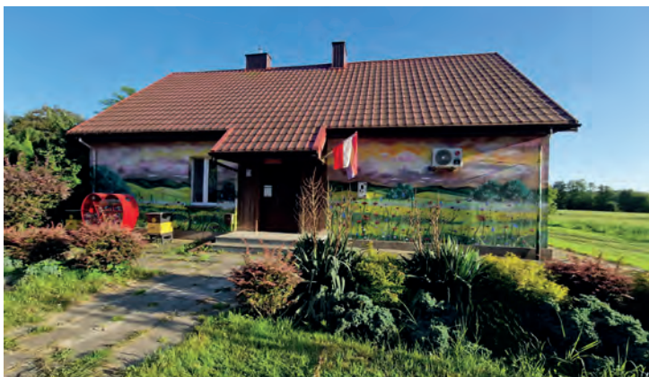
Budynek starej szkoły, obecnie Świetlica Wiejska w Krzywcu, 2025.
