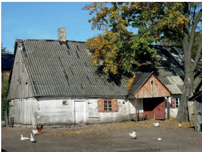
Stary dom w Krzywcu – stan przed rozbiórką. Fot. I. Powalska
