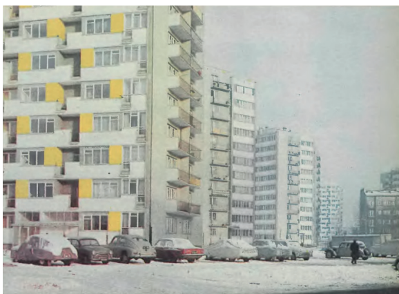
Il. 4. Elewacje budynków na osiedlu Aleje Jerozolimskie-Zachód zostały ożywione m.in. jaskrawożółtymi płaszczyznami, które przechodziły do wnętrza loggii, co drugie piętro – raz z jednej, raz z drugiej strony. Dzięki temu zabiegowi otrzymano efekt podkreślenia znacznych zagłębień w powierzchni elewacji. Zastosowana żółta barwa bardzo dobrze współgrała z powierzchniami pomalowanymi na biało i szaro [Fot. Henryk Jurko, „Stolica” 1970, nr 3, s. 21]
