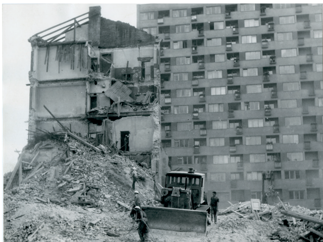
II. 3. Rozbiórka frontowej kamienicy przy ul. Pańskiej 67 na przełomie lat 1968 i 1969. W tym miejscu powstał budynek przy ul. Żelaznej 40, część pawilonu Spółdzielni „Wspólna Sprawa” oraz fragment zielenicy na osiedlowym podwórku. W tle elewacja budynku przy ul. Pańskiej 65, zasiedlonego w sierpniu 1968 r. [Fot. Jan Rozmarynowski]
