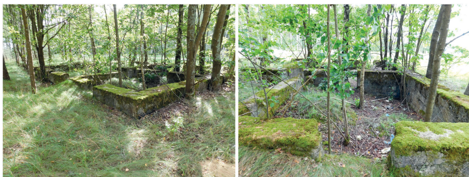
Ryc. 162. Destrukty budynku administracji byłego niemieckiego obozu jenieckiego w Dłutowie
