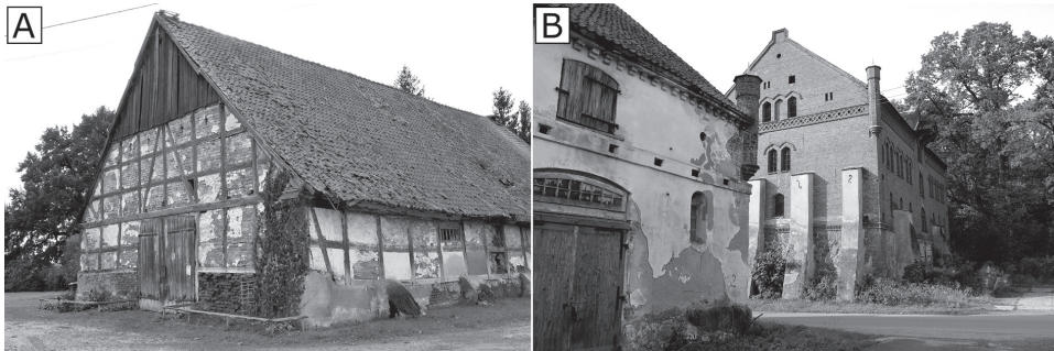
Ryc. 100. Przykłady historycznej zabudowy gospodarczej z terenu dawnych Prus Wschodnich: obiekt w konstrukcji muru pruskiego w Sątocznie (pow. Kętrzyn) (A); zabytkowy spichlerz w założeniu dworskim w Wopławkach (pow. Kętrzyn) (B)
