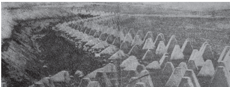
Ryc. 146. Rów przeciwczołgowy z tzw. zębami smoka, utworzony w ramach budowy linii umocnień w Prusach Wschodnich w drugiej połowie 1944 r.
