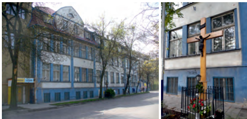
Fot. 20. Budynek byłej dyrekcji Zakładów Zieleniewskiego, ul. Grzegórzecka 69, krzyż postawiono w 1981 r.
