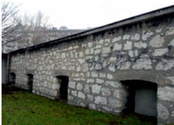
Fot. 4. Mur dawnej prochowni Bastionu VI, krakowskich fortyfikacji z 1866 r., ul. Kotlarska 34
