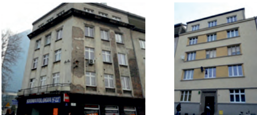
Fot. 5. Zabudowa czynszowa wschodniej pierzei ul. Kotlarskiej nr 2 i 4 z lat 30. XX w. Źródło: fot. M. Sobczyński
