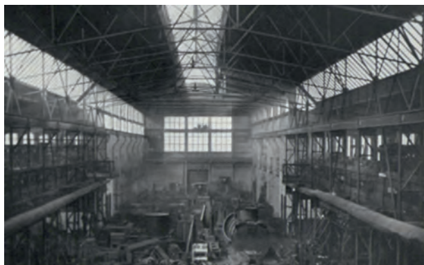
Fot. 12. Hala budowy maszyn w Zakładach Zieleniewskiego, ul. Grzegórzecka 69 w Krakowie
