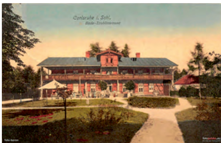
Ryc. 4. Zabudowa uzdrowiskowa Bad Carlsruhe . Domek Szwajcarski na pocz. XX wieku
