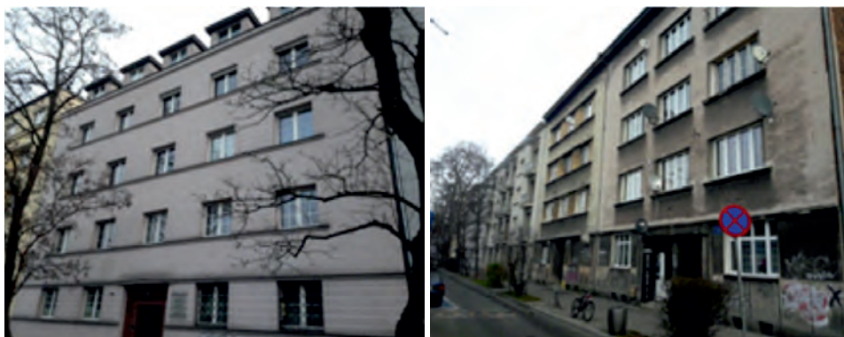
Fot. 6. Zabudowa czynszowa wschodniej pierzei ul. Kotlarskiej nr 6 oraz nr 14 i 16 z lat 30. XX w.
