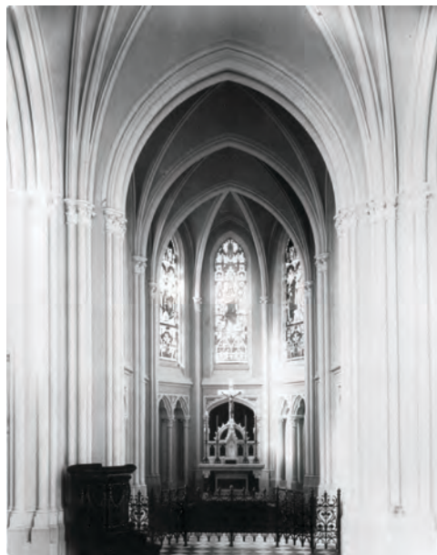
Ryc. 87. Kaplica grobowa Karola Scheiblera – wnętrze górnej kondygnacji, 1885–1888, arch. arch. Józef Dziekoński i Edward Lilpop
