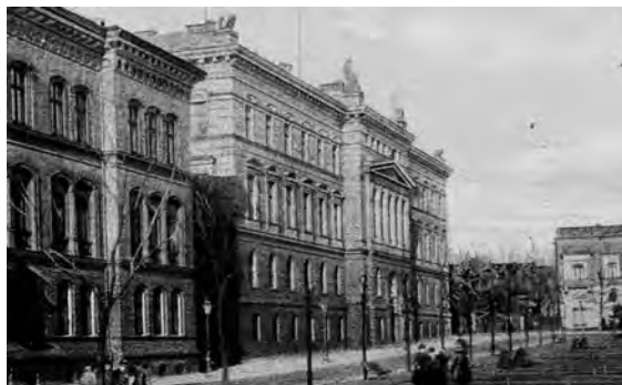
Ilustracja 2. Budynek sądu krajowego
