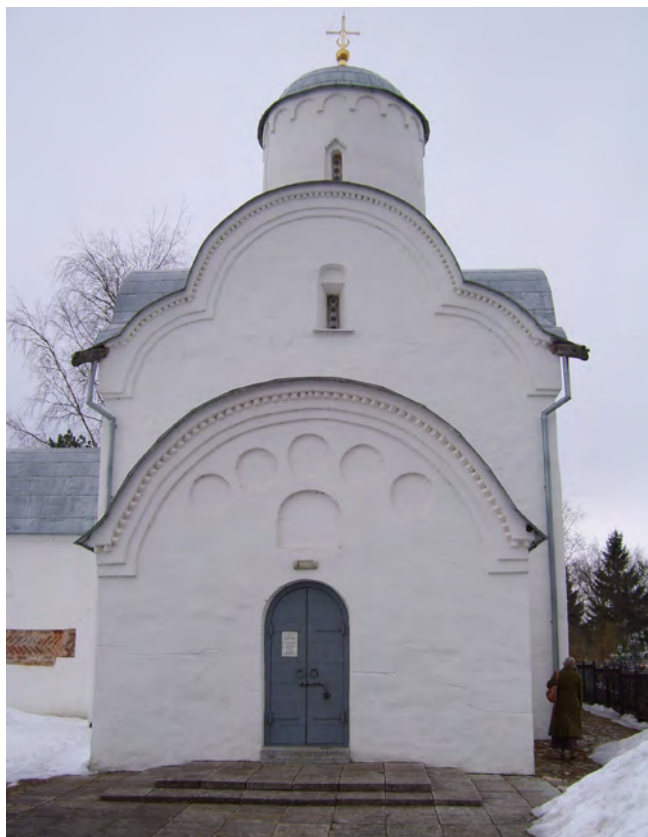
Cerkiew Zaśnięcia Bogurodzicy na Wołotowym Polu. Widok od zachodu (fotografia z 2013 r.)
