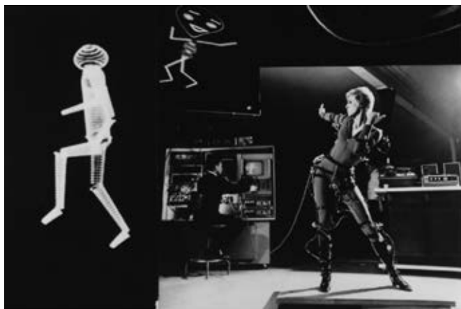
Fot. 7. Animation Harness – część systemu ANIMAC Lee Harrisona służąca przechwytywaniu ruchu tancerki
